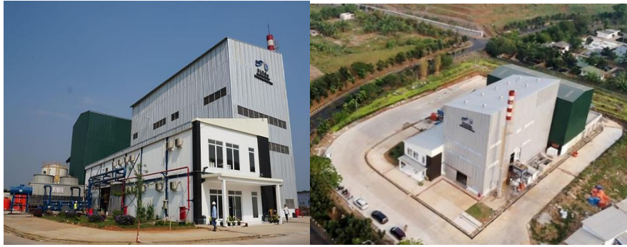
Gambar II.13. Pembangkit Listrik Tenaga Sampah (PLTSa) Merah Putih
